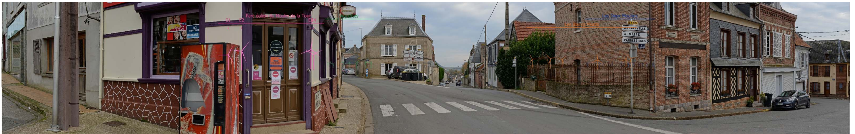
Photo 7. Cas de l'immeuble au 2 rue Sadi Carnot à Oisemont
